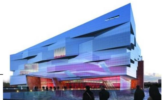
纳 800 人左右的适合话剧、戏曲表演的多功能剧场各一座，另外还将建有 4000 平方米的前厅和休息厅、电影院、纪念品精品屋和餐馆、咖啡厅等休闲娱乐场所。其功能设置，技术标准及关键舞台设备，均按国际先进水平配置。剧场在声学方面，以自然声源为主，将观众厅的体积控制在每座 7.7 立方米左右，总体积约为 12300 立方米。
